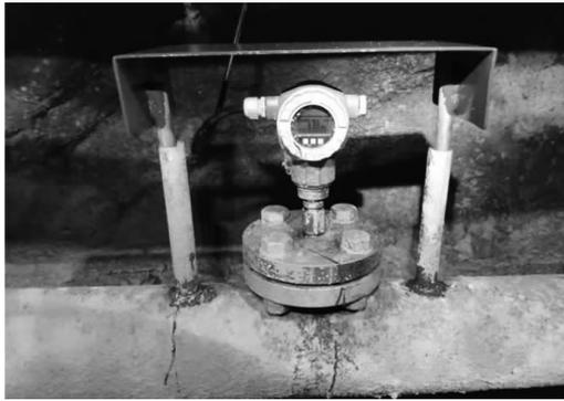
图 14 矿山井下管道压力监测表
